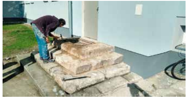
SP Błotno - remont schodów
