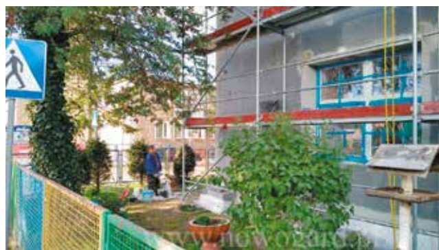
Przedszkole nr 1 ul. Żeromskiego - termomodernizacja
