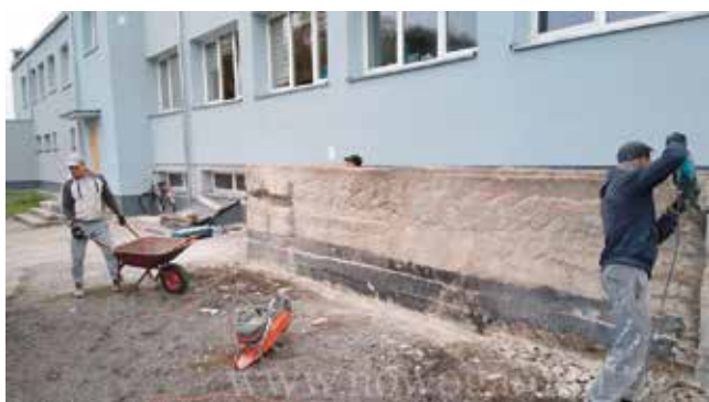
SP Błotno - przeróbka zejścia do kotłowni
