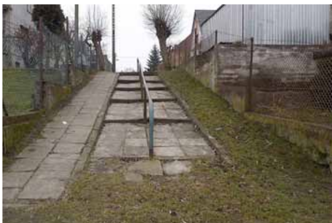
Tak wyglądało przed remontem
