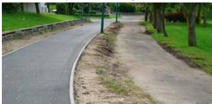
Alejki: po prawej wyremontowana lewej przed remontem
