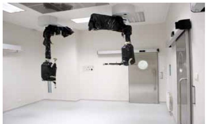
...i po remoncie
