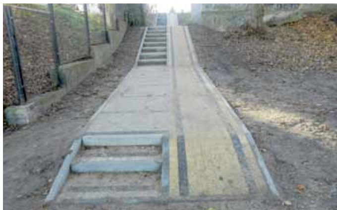
i po remoncie
