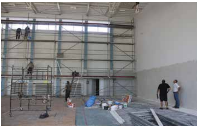
Trwa remont sali gimnastycznej w SP nr 1 str.2
