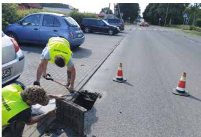
Czyszczenie studzienek kanalizacji deszczowej drogi wojewódzkiej od ul. 3 Maja - stacja Orlen do ul. G. Bema przy kościele
